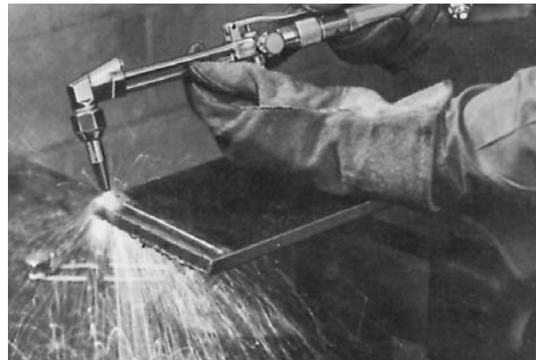
Figura 19. Corte autógeno de acero
